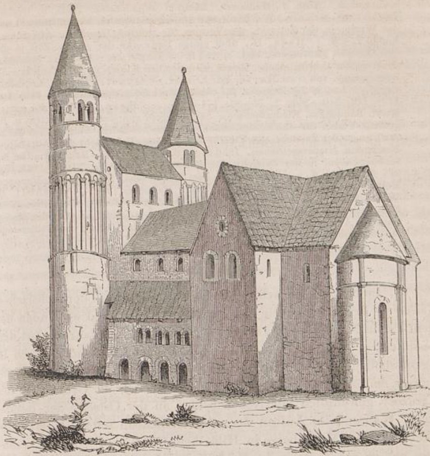
(Fig. 179. Stiftskirche in Gernrode (vor der Restauration).
