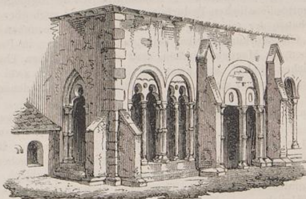
Fig. 26. Paradies der Klosterkirche zu Maulbronn (aus Leibnitz, Organisation der Gewölbe).
