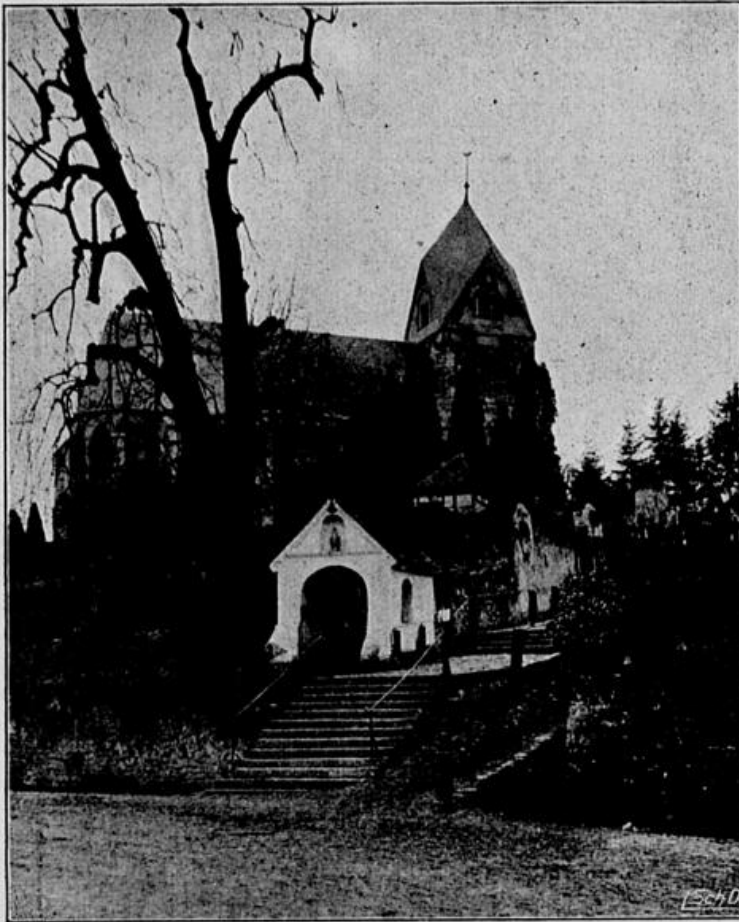
Fig. 24. Rhens. Ansicht der alten Pfarrkirche von der Landstrasse aus.
