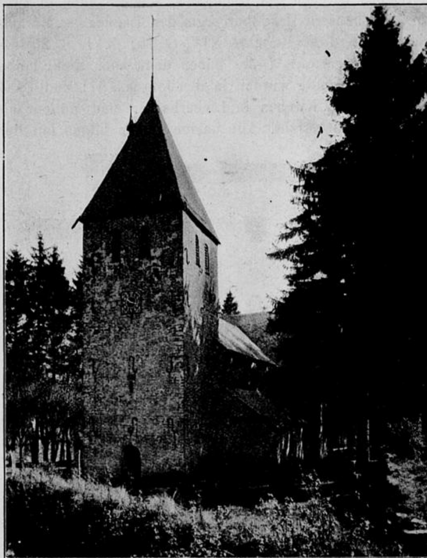
Fig. 31. Müllenbach. Ansicht der evang. Pfarrkirche.
