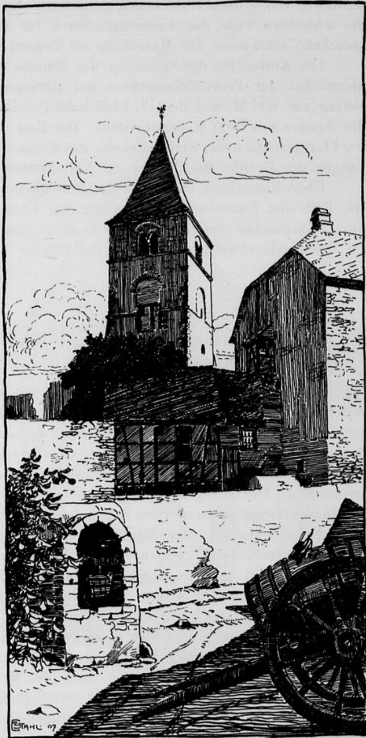
Fig. 14. Miesenheim. Turm der alten katholischen Pfarrkirche nach der Wiederherstellung.
