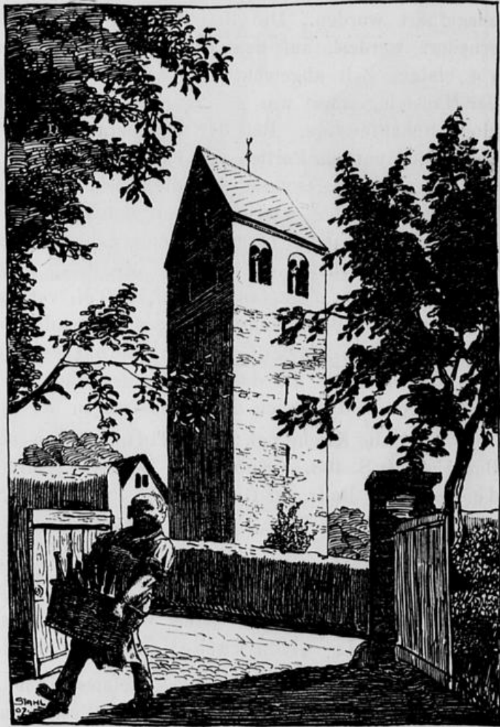
Fig. 13. Lehmen a. d. Mosel. Romanischer Kirchturm nach der Wiederherstellung.
