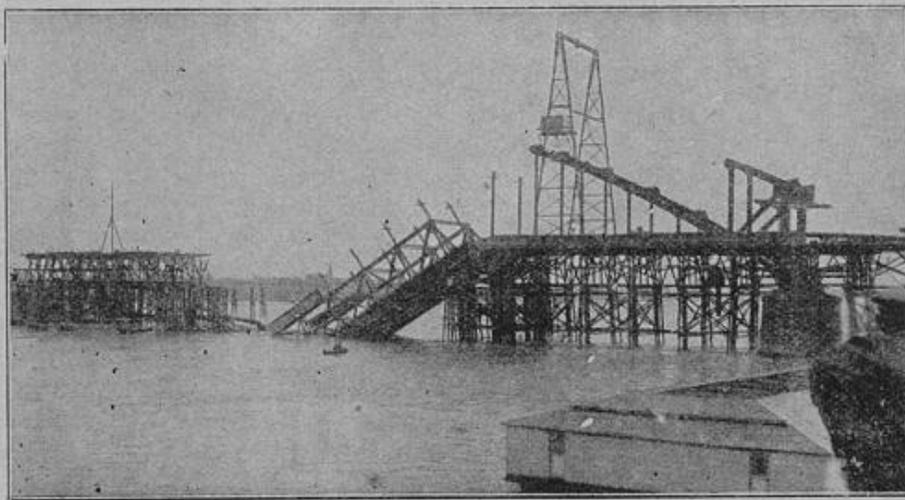
Zu dem Brückeneinsturz der im Bau befindlichen südlichen Kölner Rheinbrücke.
