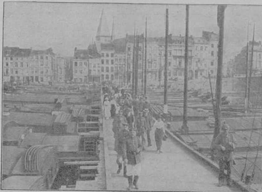
Von deutschen Truppen in 5 Stunden gebaute Pontonbrücke über die Maas, an Stelle der von den Belgieren zerstörten Steinbrücke.
