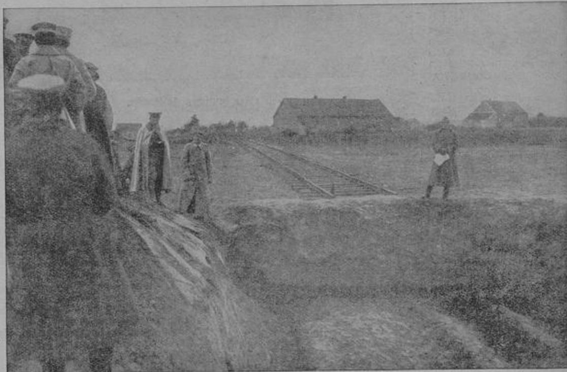
Erdgrube, in der ein 42-cm-Wörfer stand, mit anschließendem Gleis zur Weiterbeförderung des Geschützes.
