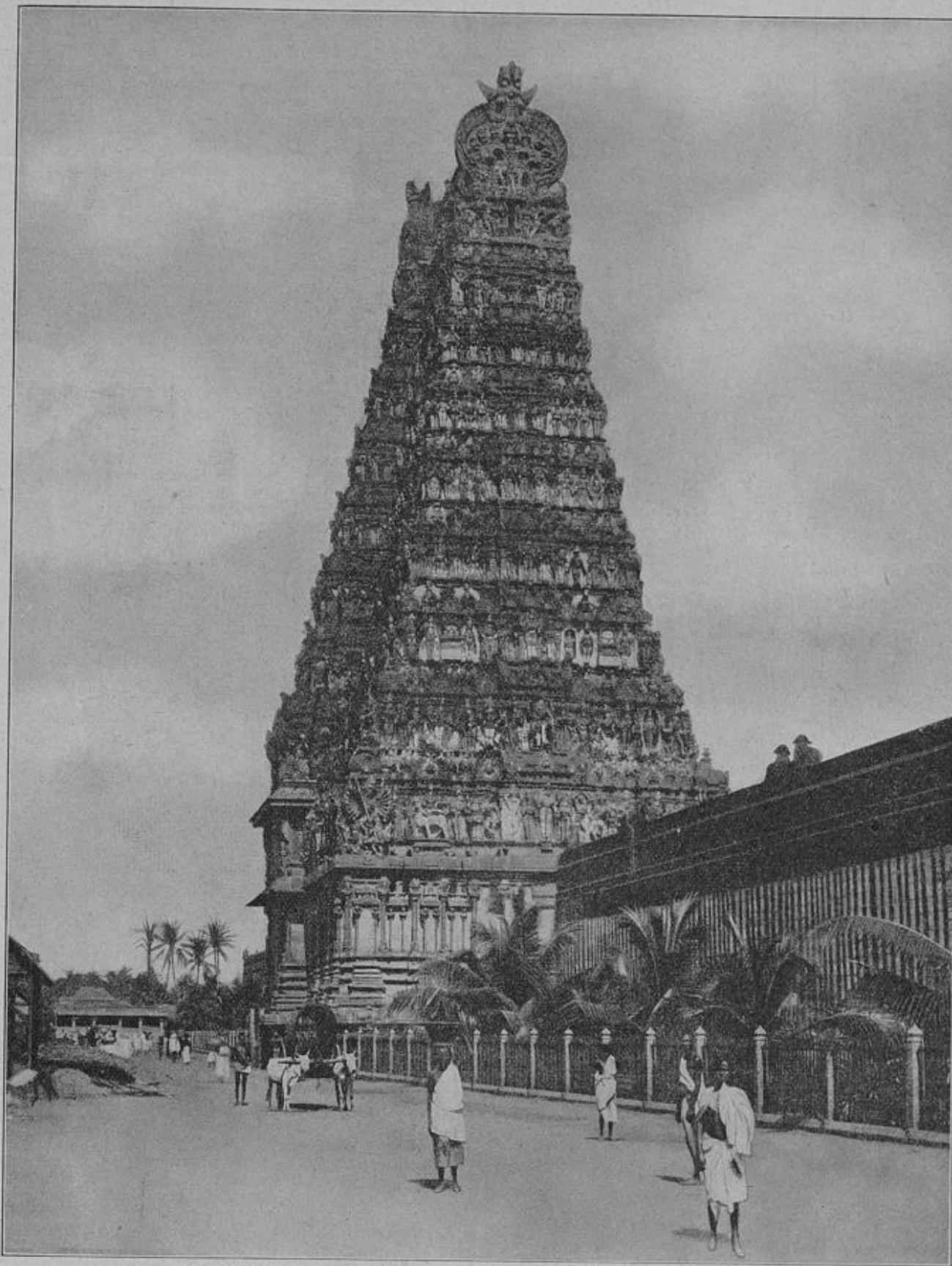
Der Gopuram des Sivatemple zu Madura in Südindien.
