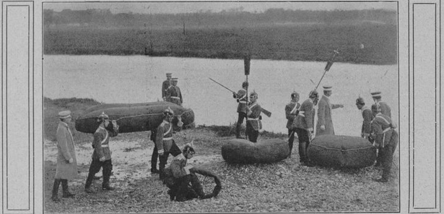
Improvisierte Flußübergänge: Fertig gefüllte Floßsäcke werden ins Wasser gesetzt.
