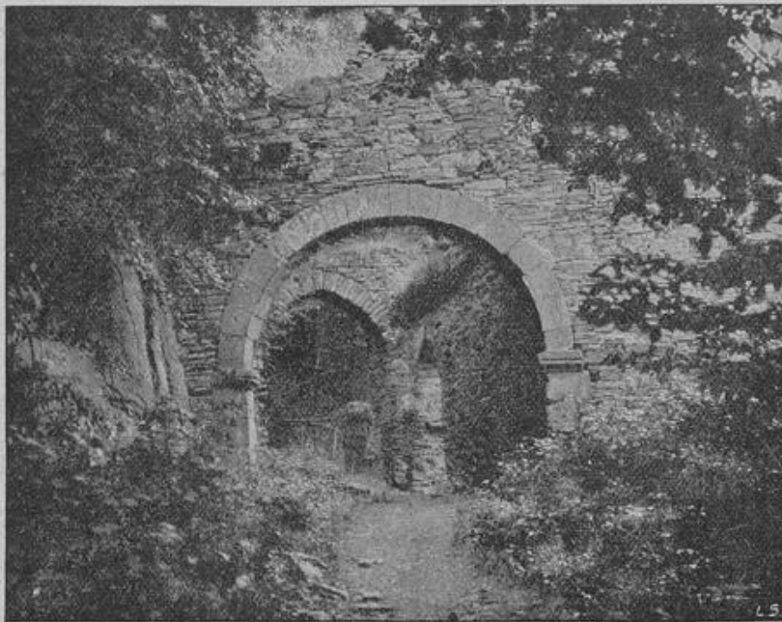
Vorhof zur Burg in Altenahr.
