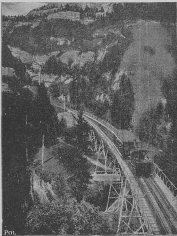
Von der Rigibahn: Die Schnurrotelbrücke.
