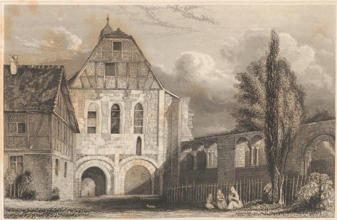
DIE KAISER PFALZ IN GELNHAUSEN.
