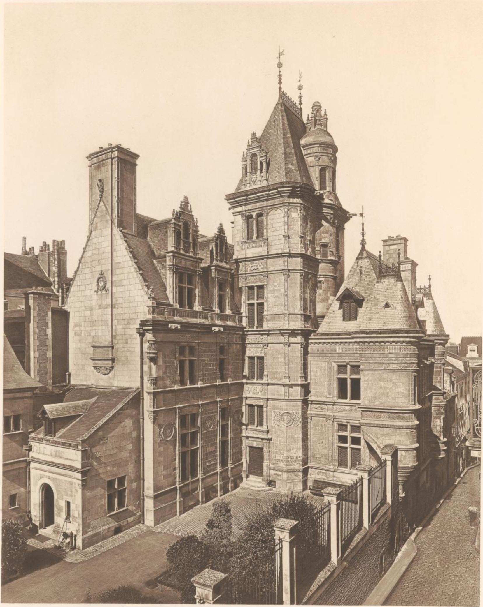
ANGERS HÔTEL PINCÉ VUE D'ENSEMBLE
