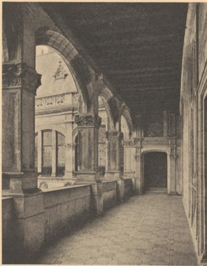
FIG. 1. — BLOIS: HÔTEL D'ALLUYE Galerie du 1 er étage
