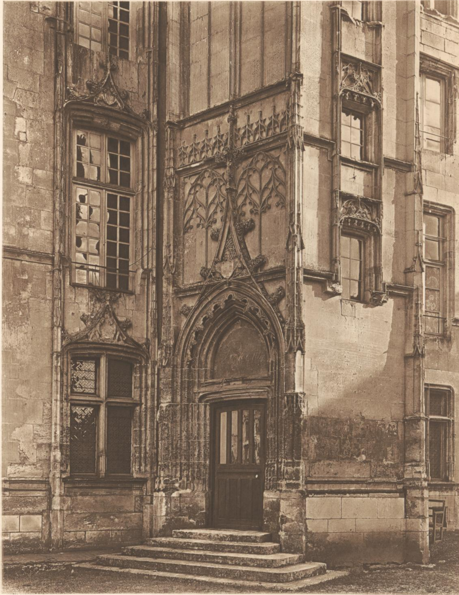
ÉVREUX ANCIEN ÉVÊCHÉ ENTRÉE DE L'ESCALIER
