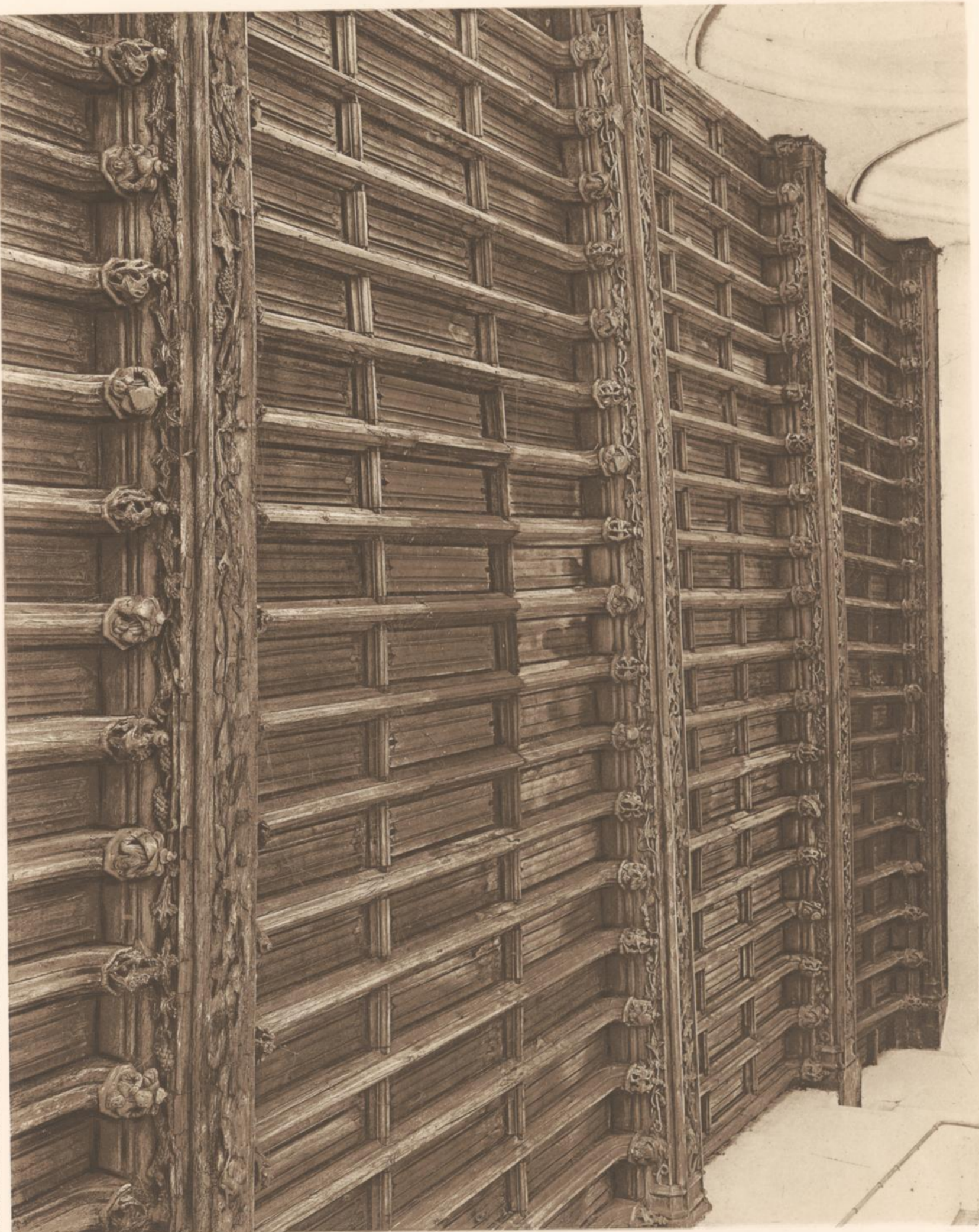
REIMS MAISON COUVERT PLAFOND DE LA GRANDE SALLE
