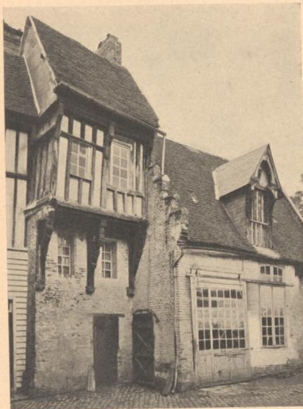
FIG. 45. — ABBEVILLE : MAISON DITE DE FRANÇOIS I er Aile sur la cour
