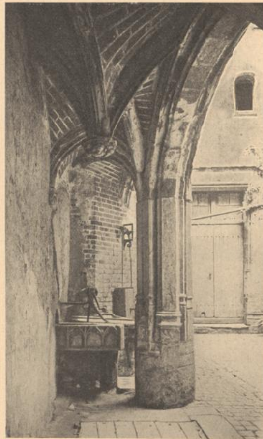
FIG. 10. — TOURS : MAISON DITE DE TRISTAN Portique sur la cour
