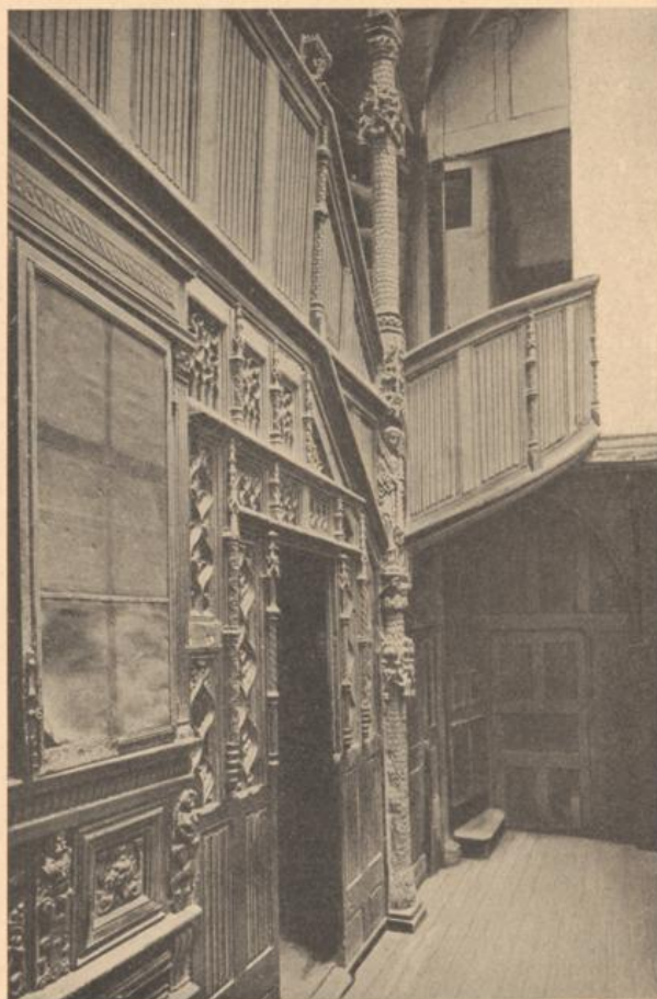
FIG. 43. — MORLAIX: MAISON POULIQUEN Départ de l'escalier
