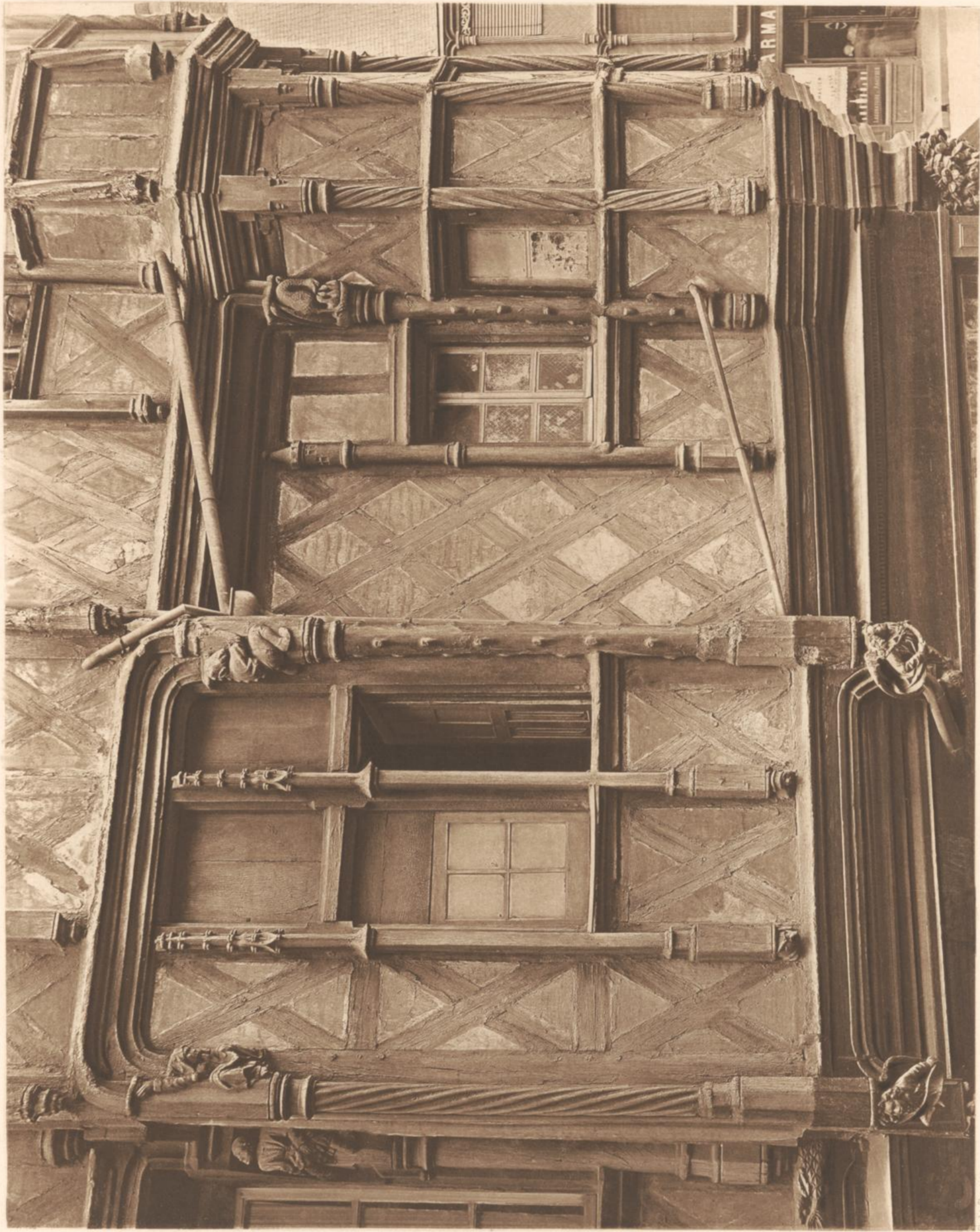
ANGERS MAISON D'ADAM DETAIL DE LA FACADE OUEST
