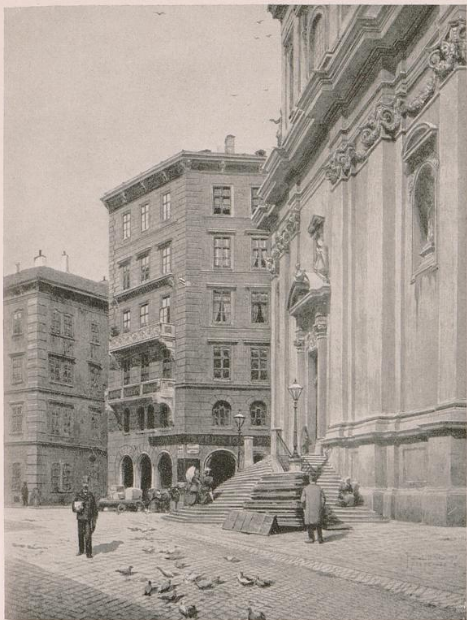
Das von den Architekten Van der Nüll und v. Siccardsburg 1852 erbaute Gerold'sche Haus, Postgasse Nr. 6.
