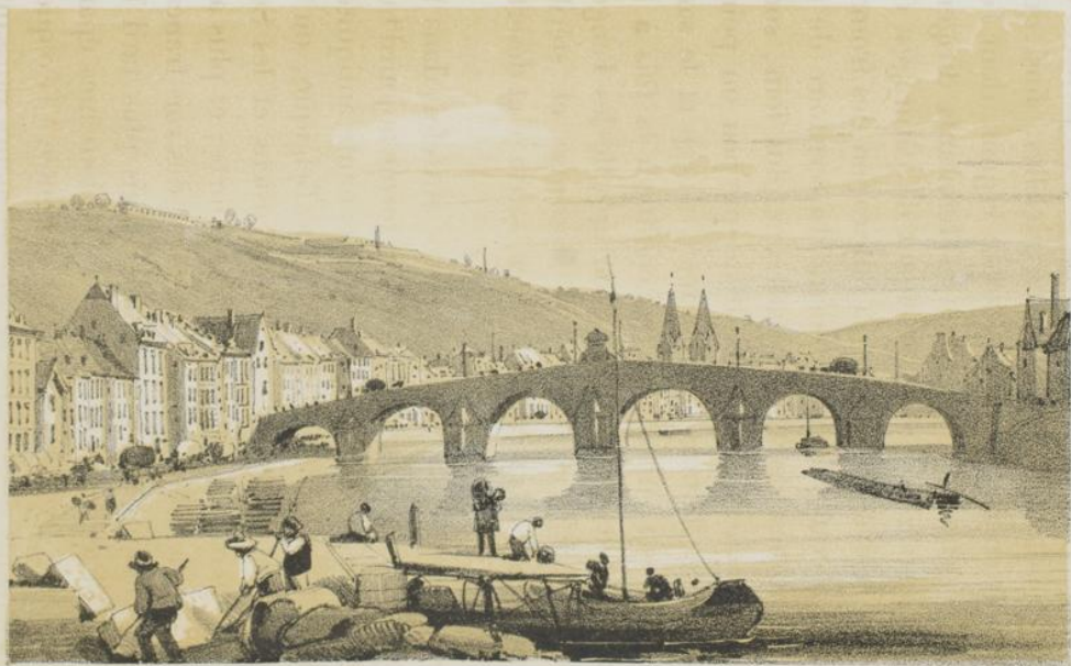
LE PONT DES ARCHES A LIEGE
