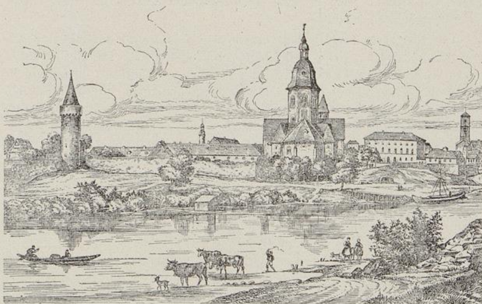
Abb. 72. Blick auf die Abteikirche Seligenstadt vom rechten Mainufer.
