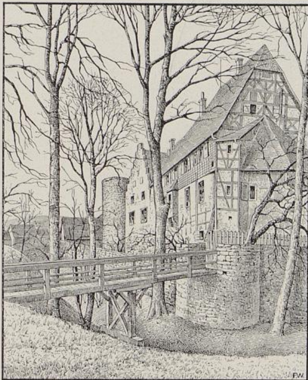
Abb. 80. Die Kellerei in Michelstadt von Südosten.
