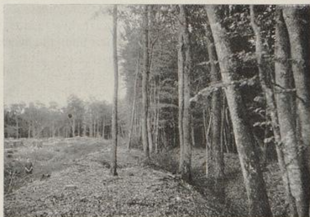
Abb. 55. Die Römerstraße Stromberg—Simmern beim Forsthaus Tiergarten.
