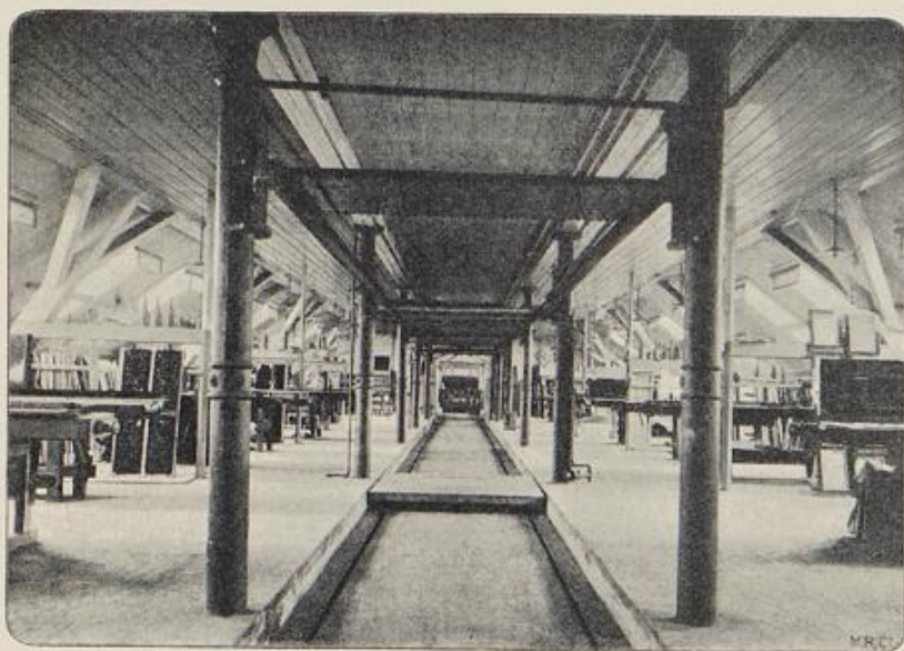
Arbeitsaal in Schwelm.
