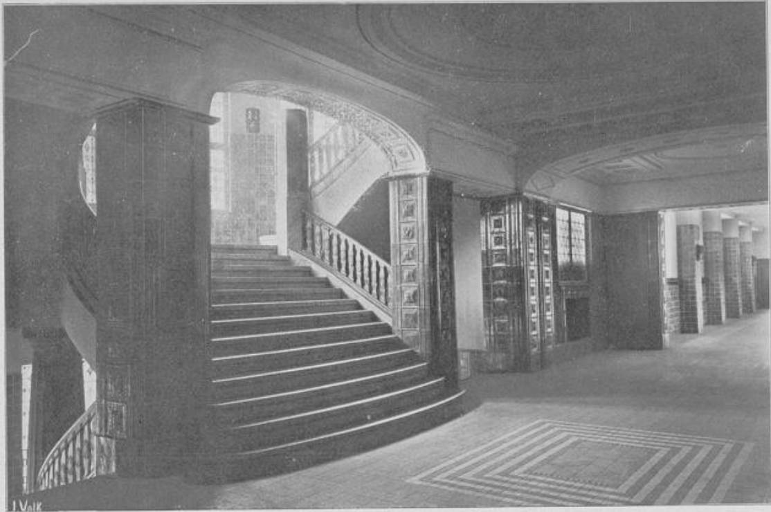
Halle mit Haupttreppe im I. Obergeschoß.
