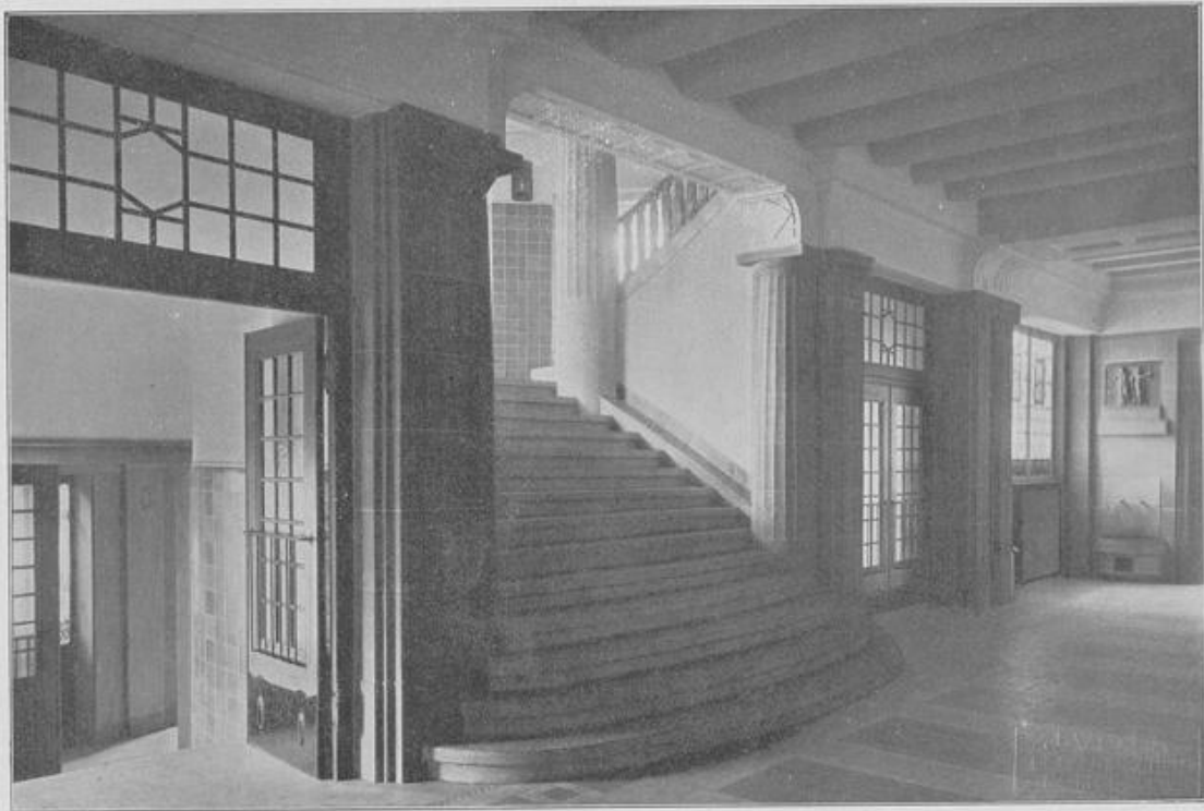
Halle mit Haupttreppe im I. Stock.
