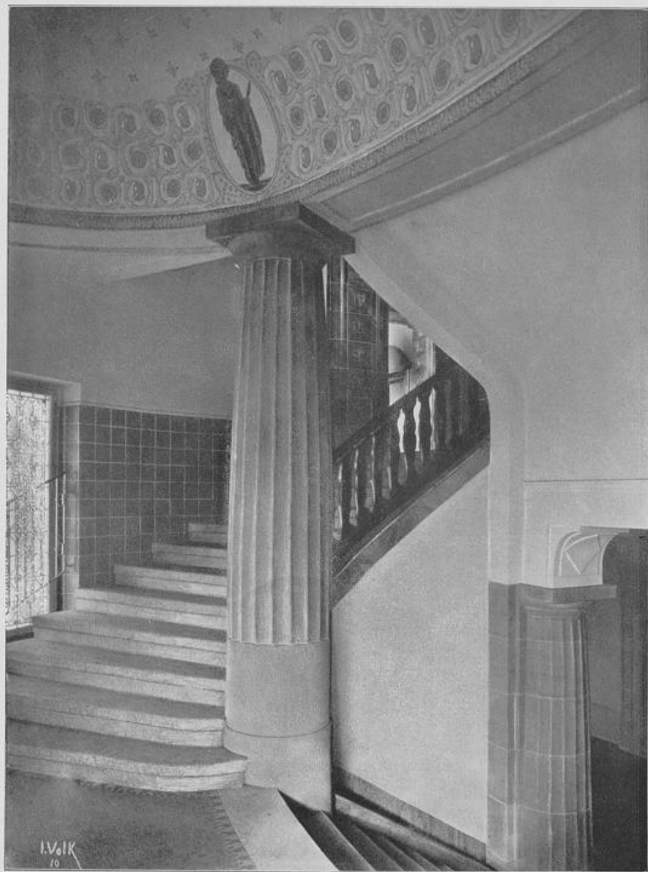
Blick vom I. Treppenpodest nach den Hallen des Erdgeschosses und I. Obergeschosses.
