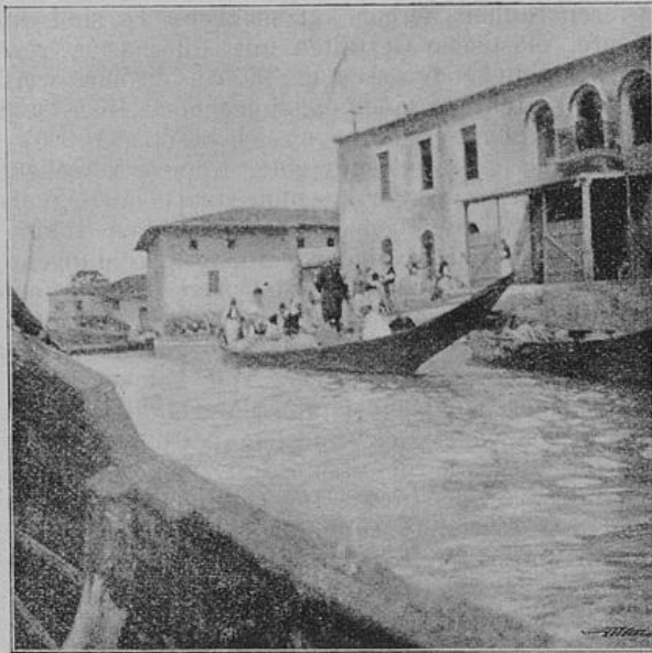
Abb. 4. Albanien. — Landungsplatz und Zollgebäude in Skutari.
