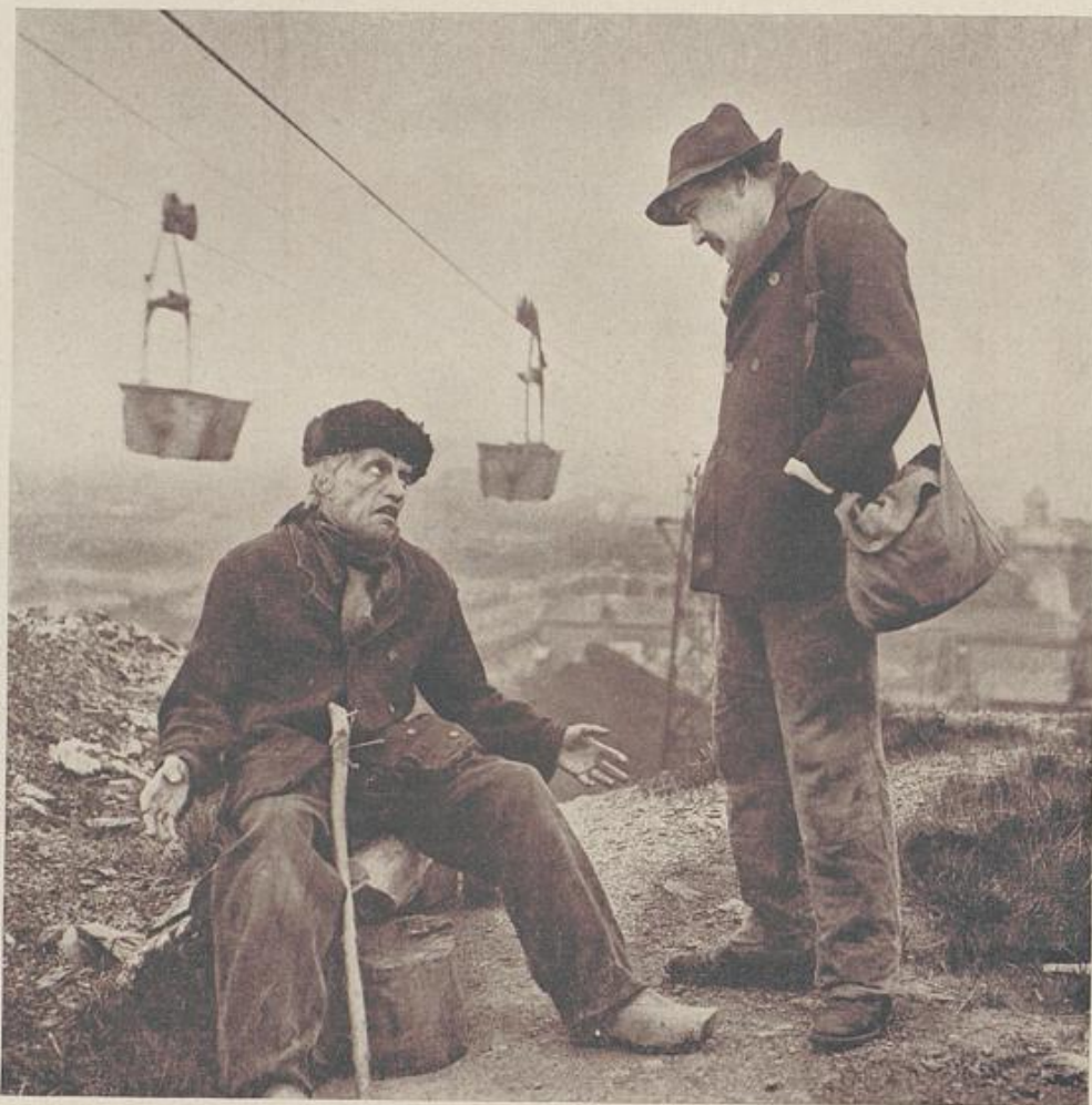
Stephan Lantier und der alte Bonnemort
