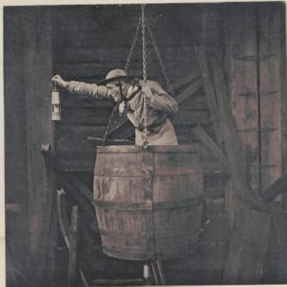
Abstieg in den Schacht
