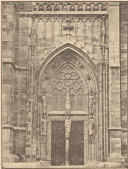
Abb. 69. Südportal der Wiesenkirche.
