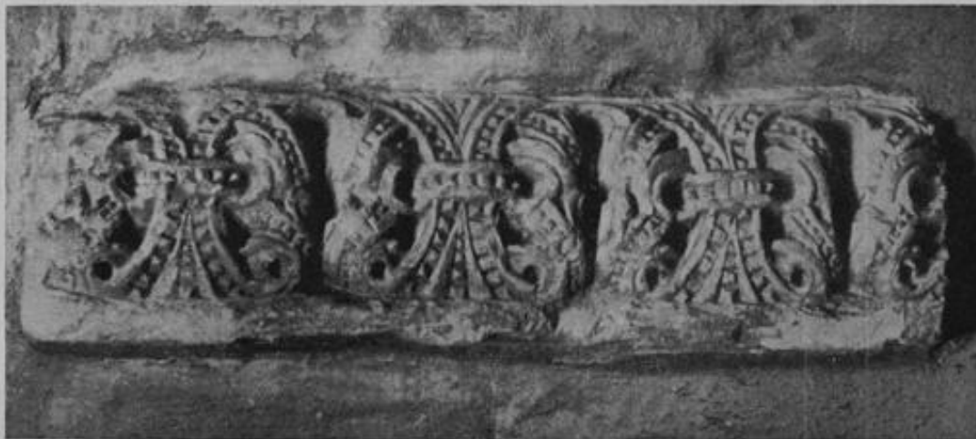
Romanisches Gesimsstück an der Verbindungsmauer Prinzipalmarkt 44/45
