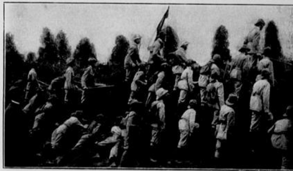
Fertig zum Vorbrechen und Sturm.
