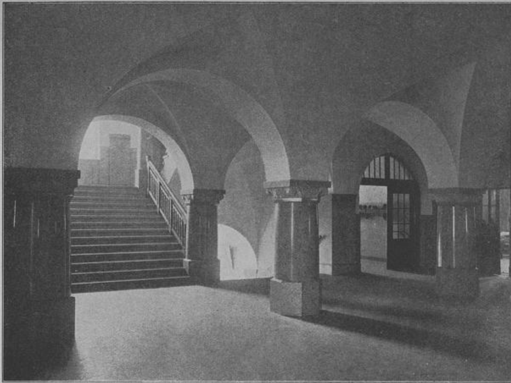
Wandelhalle im I. Obergeschoss
