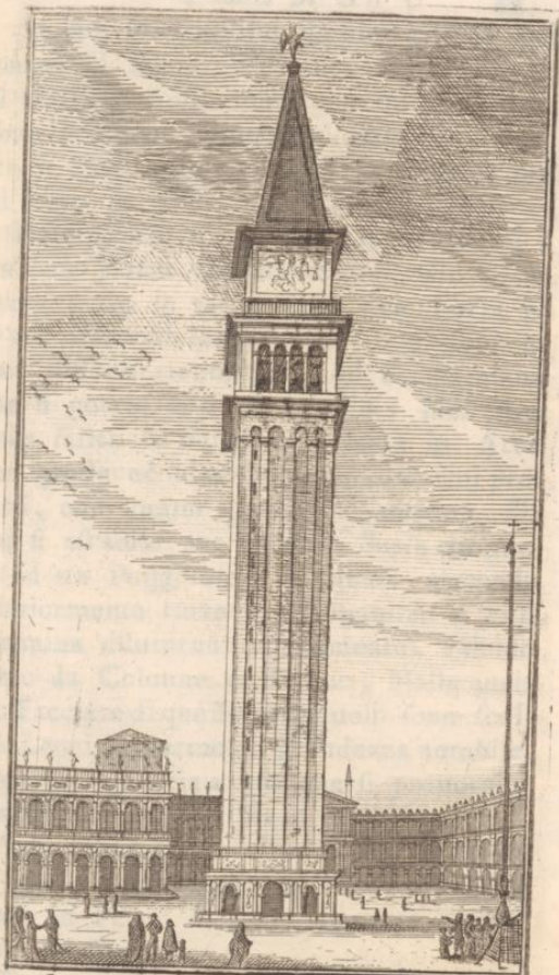
Campanile nella Piazza di S. Marco . 1765
