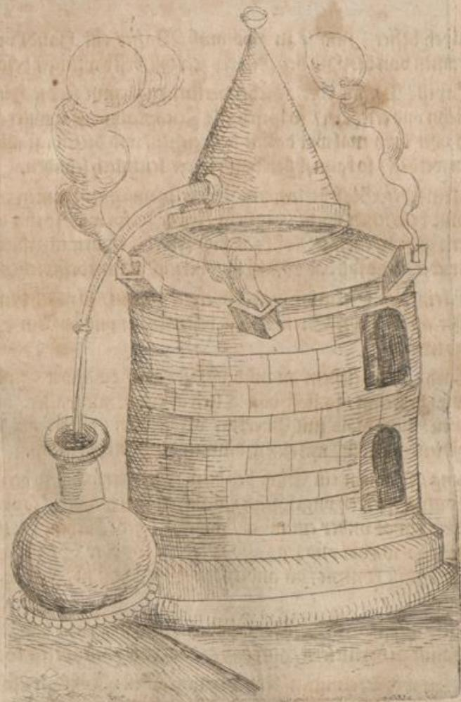
**D**ergleichen werden auch Defen mit zweyen / dreyen / oder vier Kolben gemacht / welche Kolben man mit einem einzigen Feuer kan erwärmen / vnd in einem jeden ein besondere Wasser
