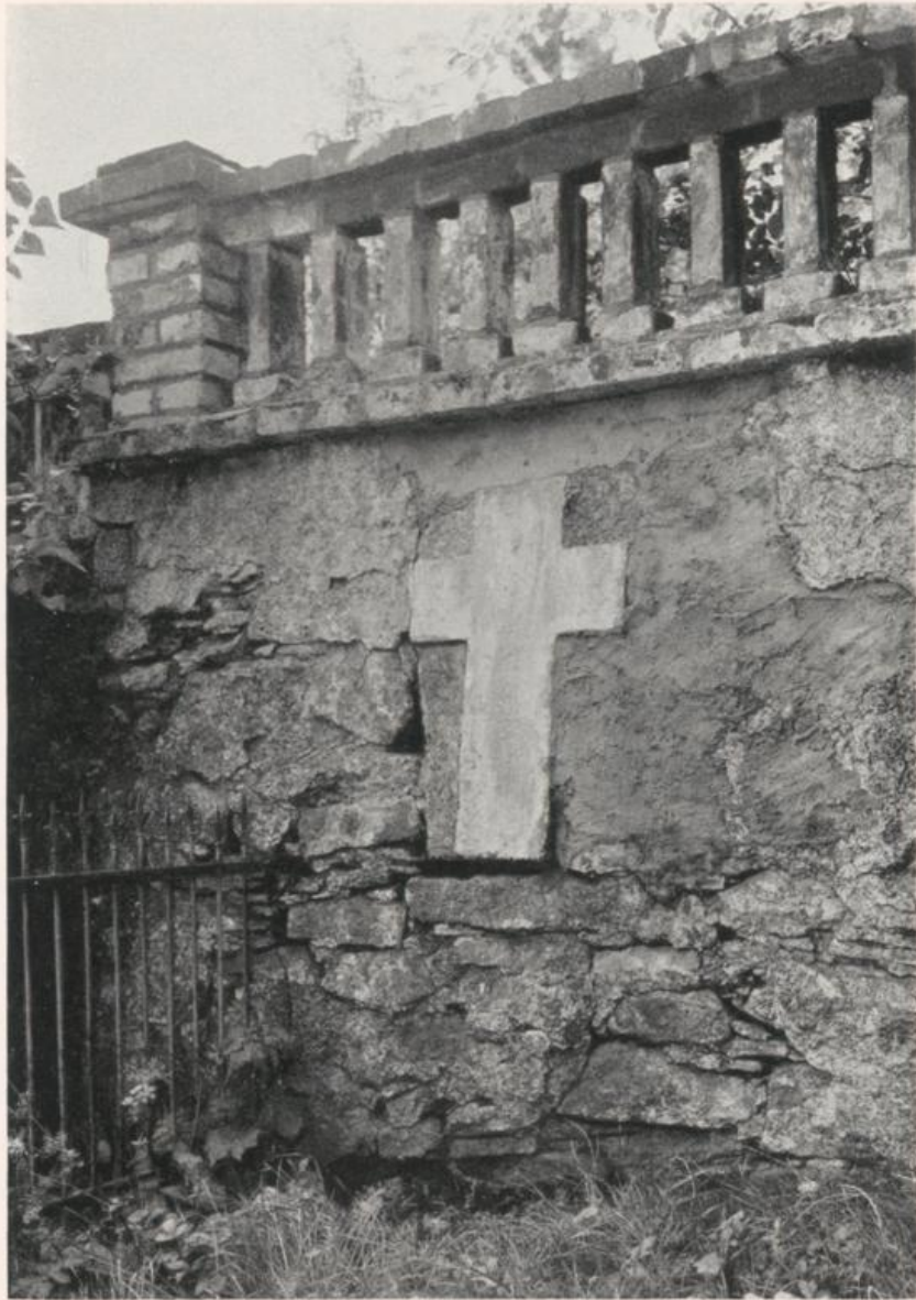
Abb. 141 Großhartmannsdorf bei Freiberg
