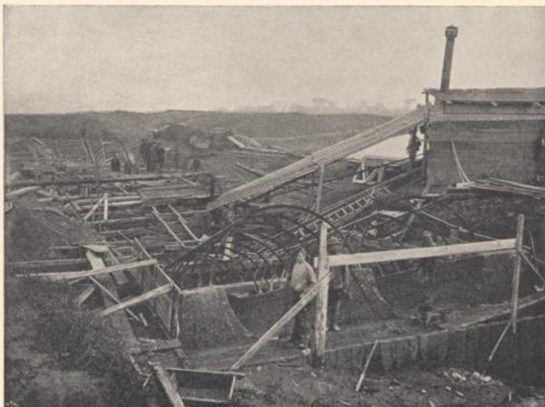
Der Aalbachdüker im Bau.
