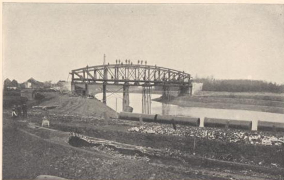
Hansbrücke im Bau.
