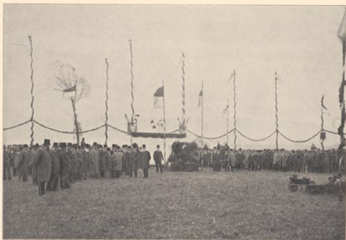
Der erste Spatenstich zum Hafen am 9. Oktober 1895.
