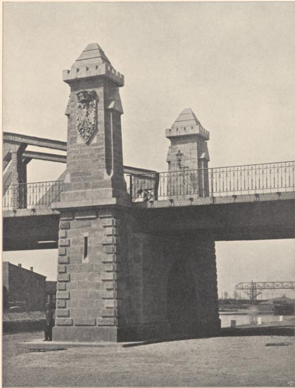
Pfeiler der Stadthafenbrücke.
