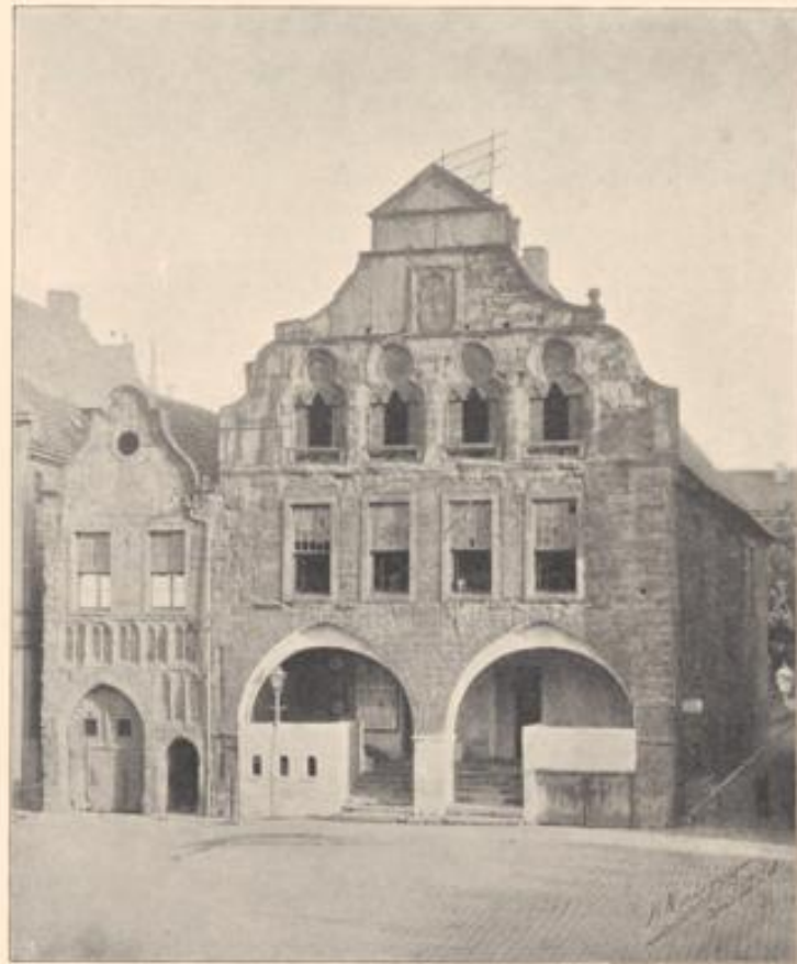
Das Rathhaus vor seiner Wiederherstellung.
