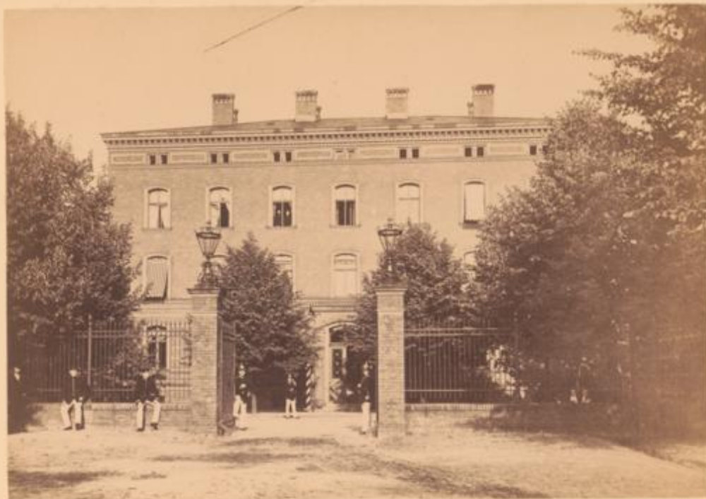
Garrison-Lazareth Berlin II (Tempelhof), Verwaltungs-Gebäude.
