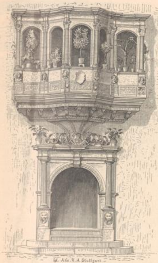
174] Erker von einem Hause in Colmar. Erbaut 1575.
