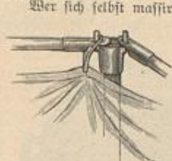
Befestigen der Stangen an den Capfeilern zum Badezelt.
