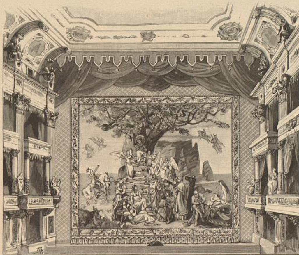
Proscenium des Opernhauses mit dem neuen Vorhang.
