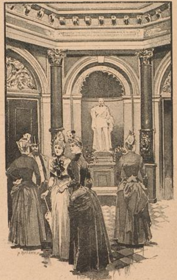
Vestibül des Geschäftshauses in Landeshut.
