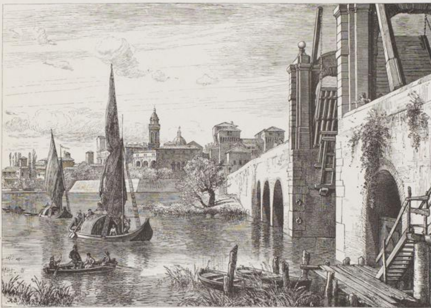
BLICK AUF MANTUA BEI PONTE SAN GIORGIO.
