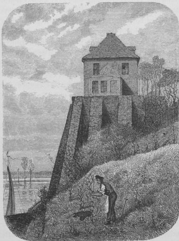
Die Wöschungsmauern der Burg Tangermünde an der Elbseite.
