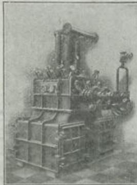
**Vakuum-Trockentrommeln** für flüssige und breiartige Produkte. Trocknung in wenigen Sekunden, kontinuierlich arbeitend. wenig Handarbeit, große Leistung.
