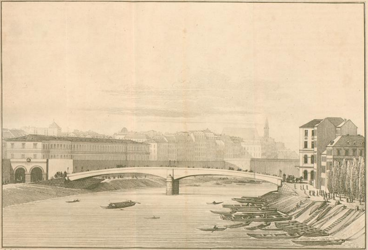
SCHLAGBRÜCKE IN WIEN.
