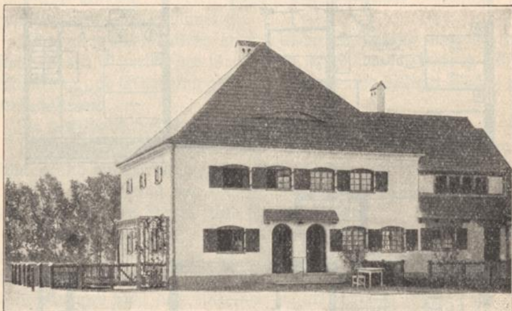
Abb. 13. Ansicht der Häuser von Abb. 12.
