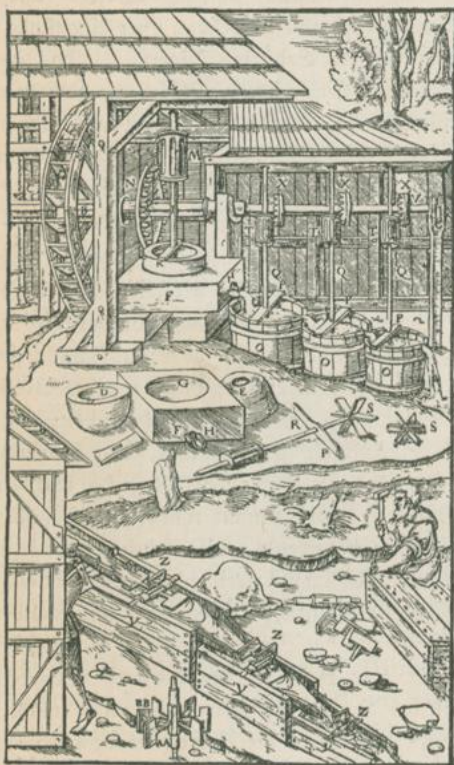
Fig. 22. Goldgewinnung mittels Amalgamationsverfahren nach einem Holzschnitte vom Jahre 1557.
