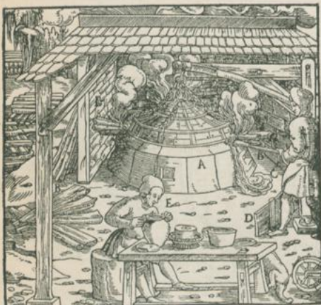
Fig. 26. Treibherd nach einem Holzschnitte vom Jahre 1557.
