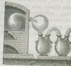
Vorlagen nach dem System der Woulf'schen Flaschen.
