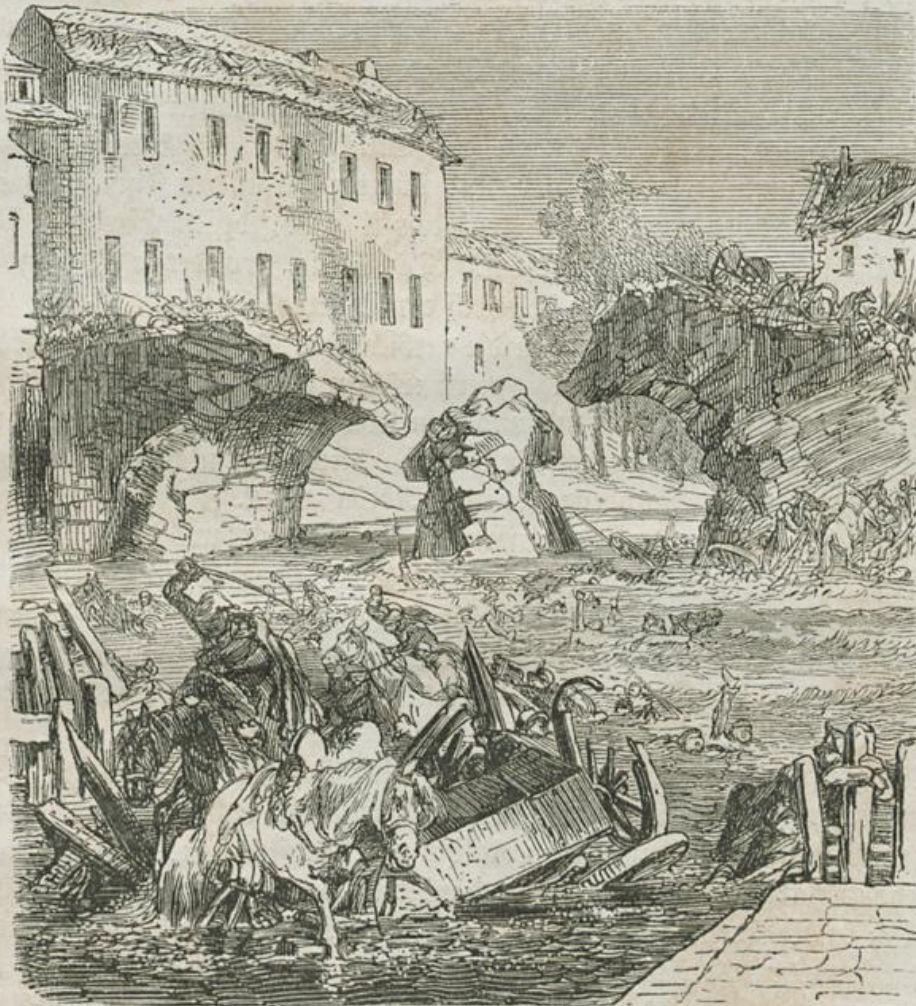
Die Trümmer der gesprengten Elsterbrücke.
