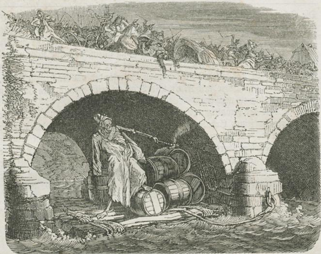
Explosion der Elsterbrücke bei Leipzig.
