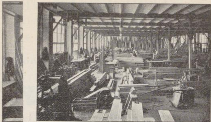
VUE D'UNE DES SALLES DES MACHINES
