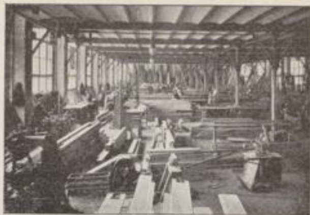
VUE D'UNE DES SALLES DES MACHINES
