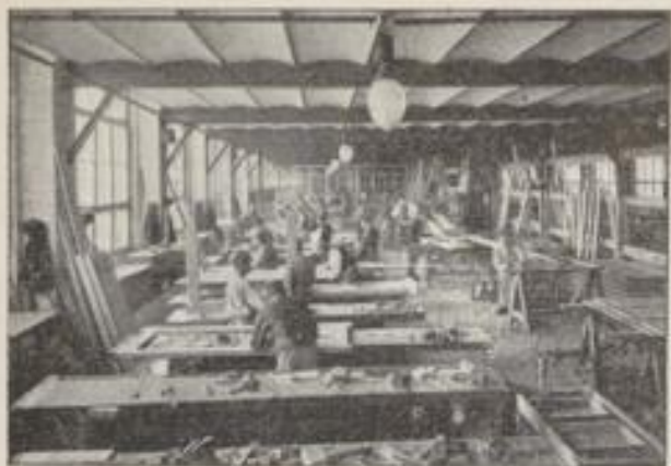
VUE D'UN DES ATELIERS
