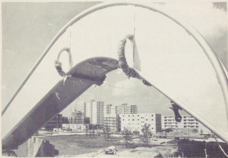
Neubaugebiet Ratingen-West, in 10 Jahren für 17.000 Menschen gebaut
